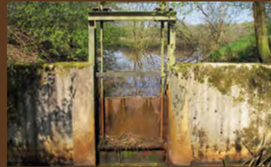
Das Stauwehr vor der Sanierung
