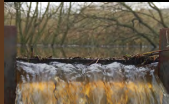
Das Stauwehr nach der Sanierung
